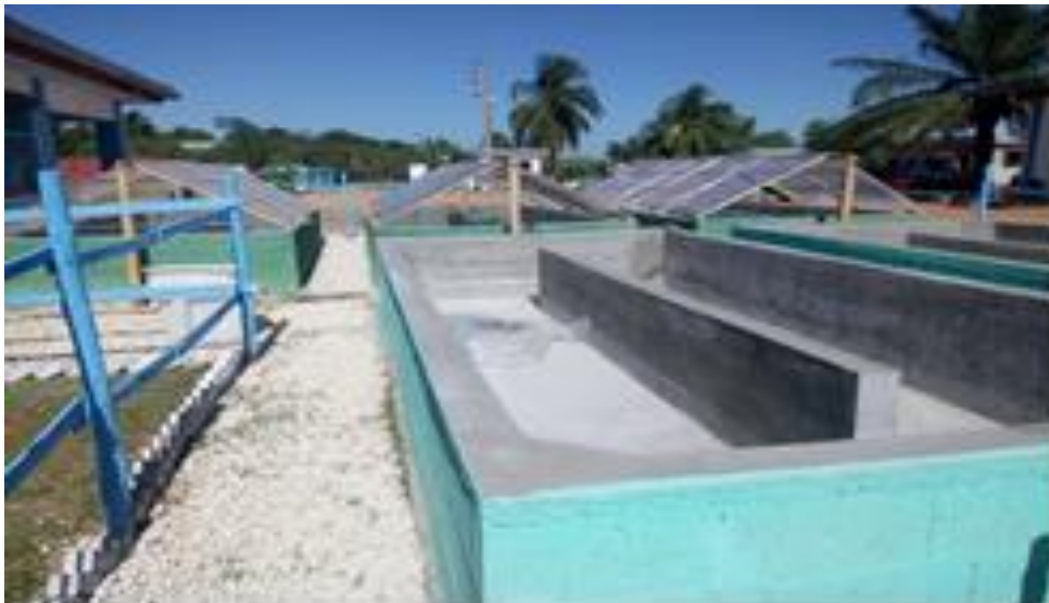
Figure 2. Bassin en cours de construction
