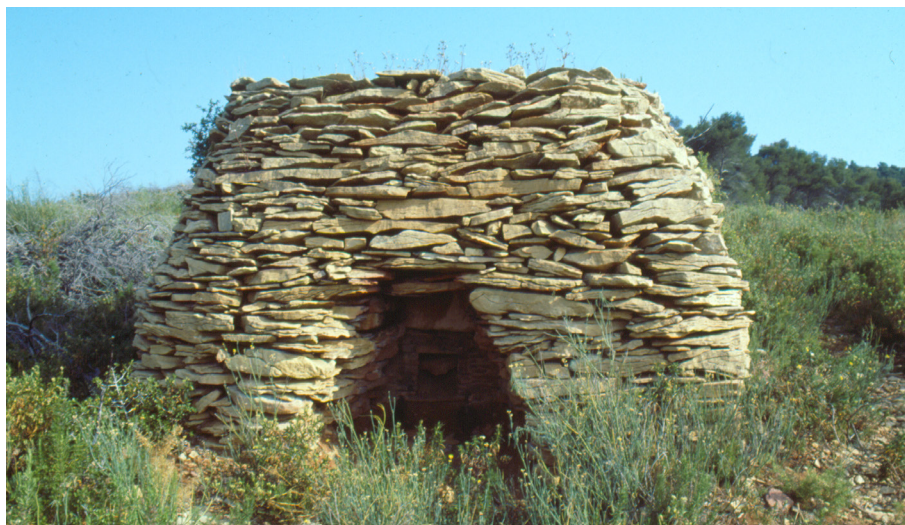
Figure 3. Vue frontale d'un four à cade dans la colline varoise. © ASER.
