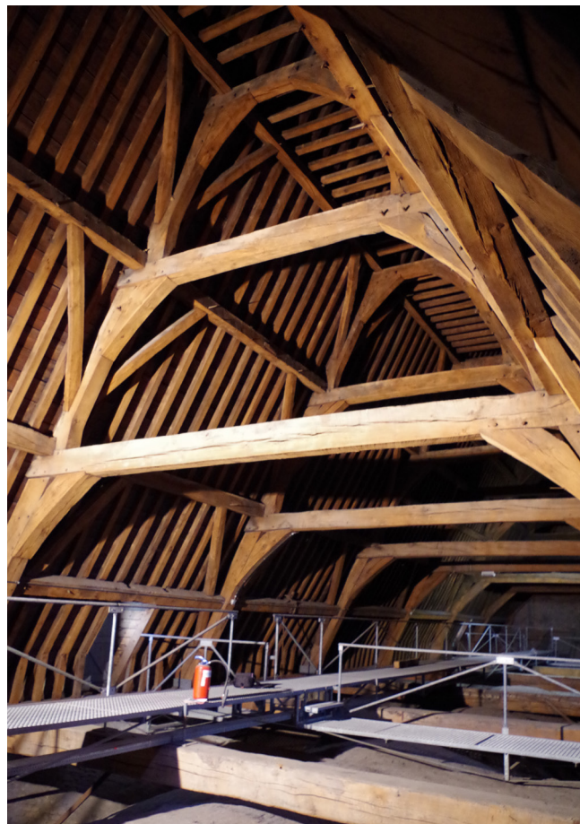
Figure 16. Exemple de fermes à portiques typique en région bruxelloise, église Notre-Dame du Sablon à Bruxelles, nef (1488d). © Labo. Dendro. IRPA, urban.brussels.
