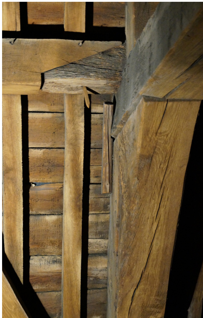
Figure 14. Vestiges de la cloison dans la nef. Montant encore en place sur l'arbalétrier et l'entrait, négatifs des planches et clous sur l'entrait, about d'une panne dégradé. © Labo. Dendro. IRPA, urban.brussels.
