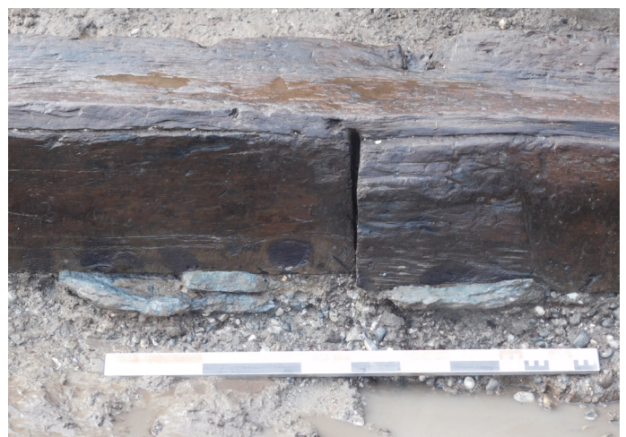
Figure 9. Calage sous les piédroits. © Éveha.
