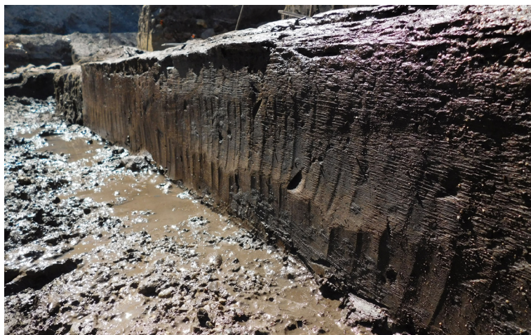
Figure 11. Exemple de traces laissées lors du sciage du piédroit 6, face externe. © Éveha.
