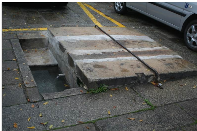
Figure 3. Photographie actuelle du bassin de captage ou puits-dépôt, la « Burga » ou « Fuego de Dios » sur la Place de Galicia, à Cuntis (Pontevedra, Espagne). © Silvia González Soutelo
