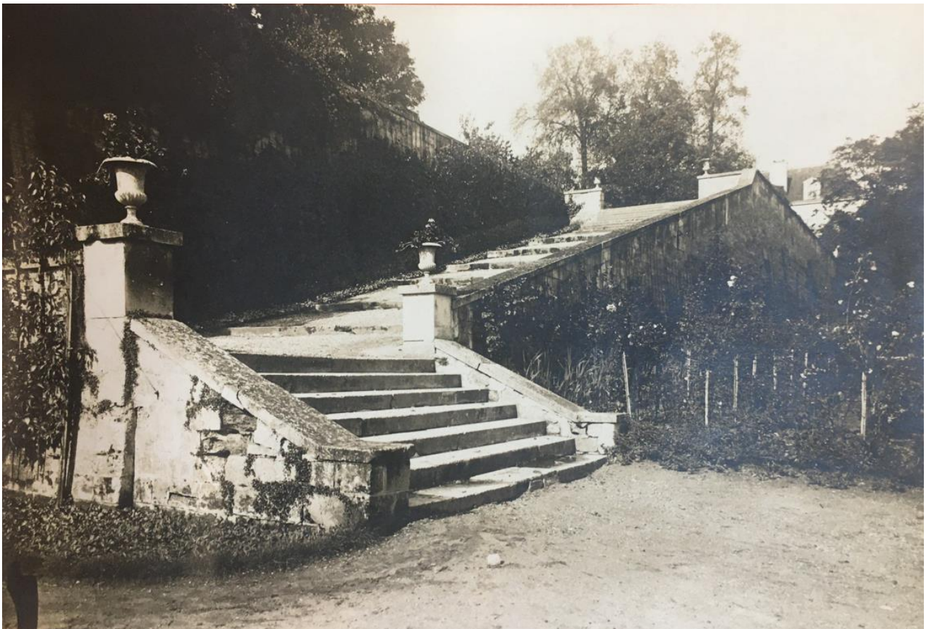
Figure 7. Rampe descendante sud de l'avancée centrale de la sixième terrasse du Château-Neuf et terrasse sous laquelle se trouvent les grottes du Pavillon Sully (cliché 7 bis présent dans le dossier de protection Monuments Historiques de 1925, archive D_1_78_43_dossier-4_A_photos, Médiathèque de l'Architecture et du Patrimoine, remerciements à Alexandre Monnier pour la photographie de cette archive). La date du cliché correspond au moment où Philippe Delaroche-Vernet était propriétaire, il est décédé au Pavillon Sully du Pecq en 1935.
