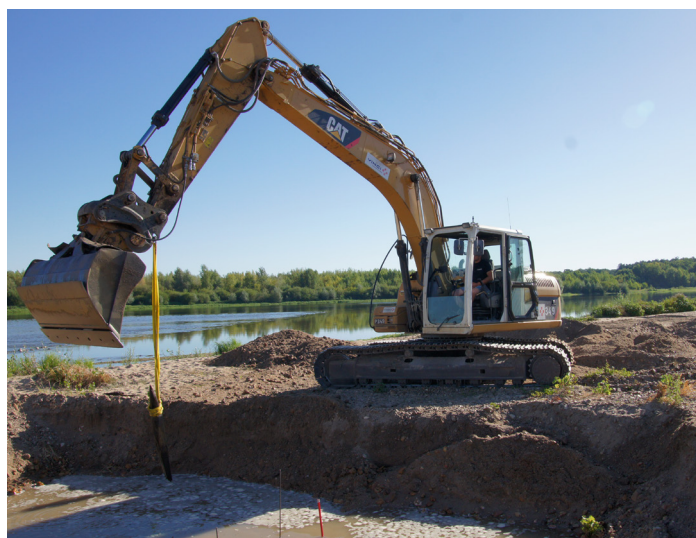
Figure 4. Prélèvement de pieux à la pelle mécanique dans les sondages ennoyés. © P. Moyat.
